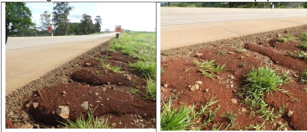
Foto 06 – Vista geral do trecho, mostrando a ocorrência de erosão no talude do aterro lateral da pista, Cascavel (PR), 01.11.2018.
