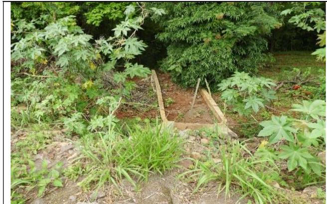
Foto 05 – Vista geral do dissipador construído, mostrando que o equipamento já se encontra bastante assoreado e com quantidade reduzida de pedras, Cascavel (PR), 01.11.2018.
