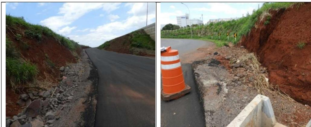
Foto 11 – Vista geral do trecho, mostrando que a sarjeta se encontra completamente destruída, Cascavel (PR), 01.11.2018.
