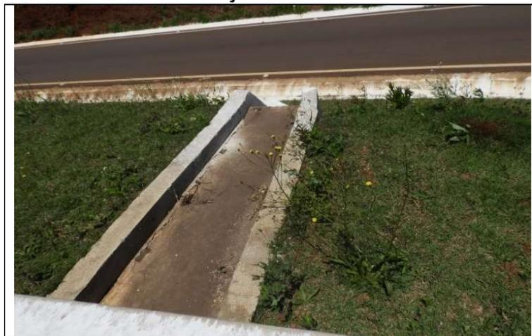
Foto 10 – Vista geral do ponto de intersecção entre a descida d'água em rap e a sarjeta, mostrando que não foi construída a caixa coletora, Cascavel (PR), 01.11.2018.
