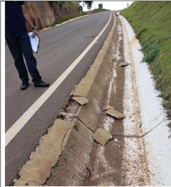
Foto 03 – 14.11.2020. Desagregação de serviço recente em sarjeta trapezoidal (marginal Esquerda). Coordenada S25 08.846 W53 35.586.
