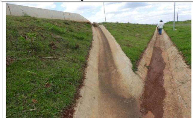
Foto 14 – Vista geral do ponto de intersecção entre a descida d'água em rap e a sarjeta, mostrando que não foi construída a caixa coletora, Cascavel (PR), 01.11.2018.
