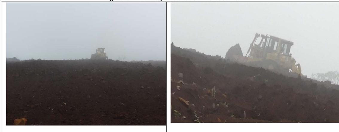
Foto 01 – Trator de esteira conformando aterro de bota-fora na Estaca 7116, BR 163 km 148,9 em 28.09.2018.
