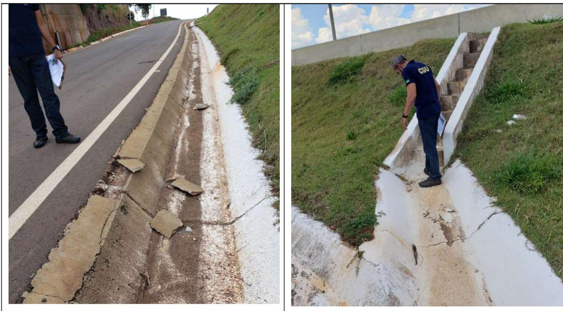
Foto 03 – 14.11.2020. Desagregação de serviço recente em sarjeta trapezoidal (marginal Esquerda). Coordenada S25 08.846 W53 35.586.
