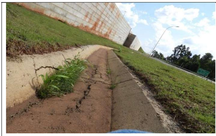
Foto 18 – Vista geral de trecho onde o equipamento de drenagem (sarjeta de canteiro central) já se apresenta parcialmente destruído, Cascavel (PR), 01.11.2018.
