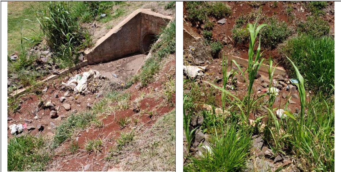
Foto 01 - 14.11.2020 - Dissipador onde ficou evidente a precariedade dos elementos de dissipação. Proximidades da OAC de acesso à Sta Tereza do Oeste. Coordenada S25 04.800 W53 34.921.
