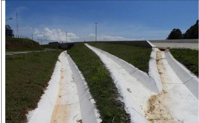
Foto 09 – Vista geral da solução técnica executada, mostrando a considerável dimensão linear da sarjeta de centro construída, bem como a sua intersecção direta (sem a presença de caixa coletora) no equipamento receptor, Cascavel (PR), 01.11.2018.
