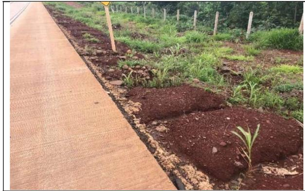
Foto 08 – Vista geral do problema de erosão talude do aterro lateral da pista, mostrando que o mesmo também está na iminência de chegar à faixa de rolamento da rodovia, Cascavel (PR), 01.11.2018.
