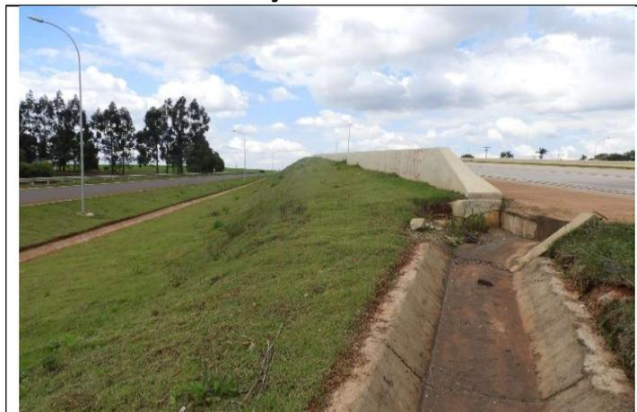
Foto 16 – Vista geral do ponto de intersecção entre a descida d'água em rap e a entrada d'água, mostrando a ocorrência de trecho parcialmente destruído, Cascavel (PR), 01.11.2018.
