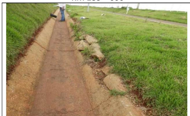
Foto 13 – Vista geral de ponto onde o equipamento de drenagem (sarjeta trapezoidal) já se encontra parcialmente destruído, Cascavel (PR), 01.11.2018.
