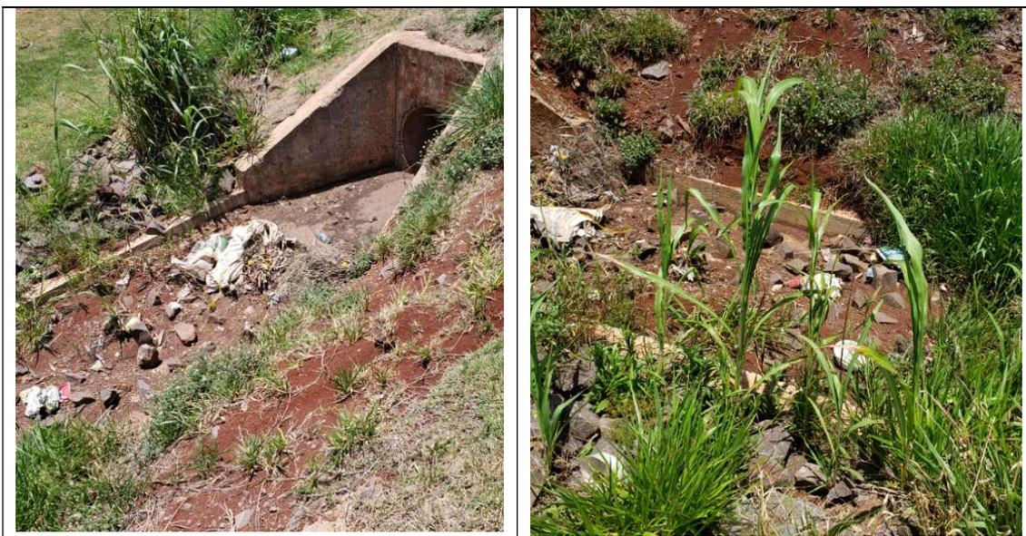
Foto 01 - 14.11.2020 - Dissipador onde ficou evidente a precariedade dos elementos de dissipação. Proximidades da OAC de acesso à Sta Tereza do Oeste. Coordenada S25 04.800 W53 34.921.
