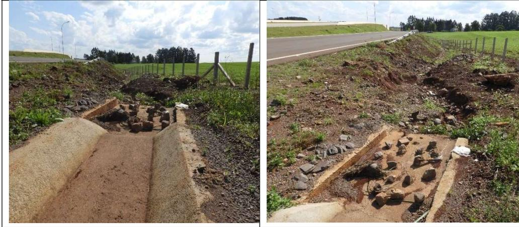
Foto 19 – Vista geral do dissipador construído na saída de trecho de sarjeta, mostrando a erosão do talude, Cascavel (PR), 01.11.2018.
