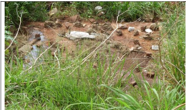
Foto 17 – Vista geral do dissipador, mostrando que o equipamento já se encontra bastante assoreado e com quantidade reduzida de pedras, Cascavel (PR), 01.11.2018.
