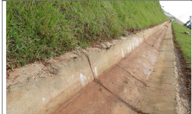
Foto 15 – Vista geral de trecho de sarjeta, mostrando a ocorrência de fissura transversal, Cascavel (PR), 01.11.2018.
